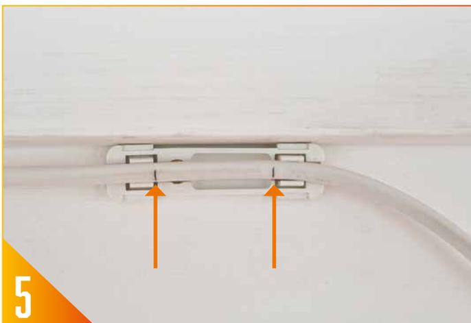
Platzieren Sie das RTRYVA Kabel im Break-Out Abzweigcover und markieren Sie Start- und Endpunkte für den Fensterschnitt.
