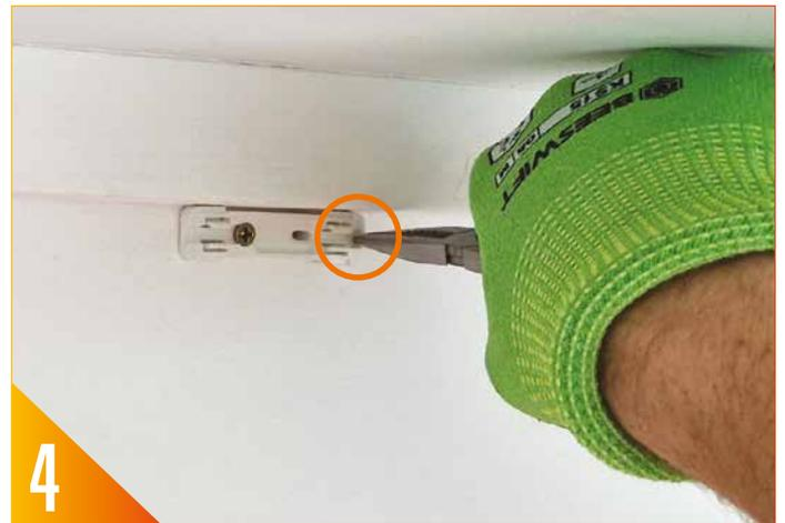
Befestigen Sie das Cover mit einer Schraube. Falls noch weitere Fasern im RTRYVA enthalten sind, entfernen Sie die Endkappe des Covers, damit die Fasern weitergeführt werden können.
