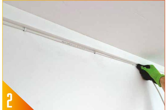
Bohren Sie die erforderlichen Löcher für alle FireClips und drücken Sie die Clips über das RTRYVA-Kabel, um es zu fixieren.
