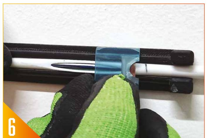
RTRYVA wieder aus Break-Out Cover entfernen und das entsprechende Werkzeug für den Fensterschnitt zum Freilegen der Fasern verwenden.
