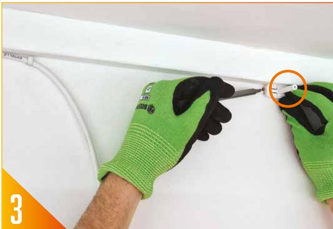
Markieren Sie mit Hilfe des Break-Out Abzweigcovers das Bohrloch und bohren Sie den Durchgang für die Faserdurchführung zur anderen Seite der Wand.
